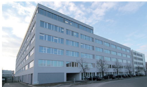
Das Großrechenzentrum in Linz
